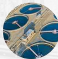
TRATAMENTO DE ÁGUA, ESGOTO E EFLUENTES
