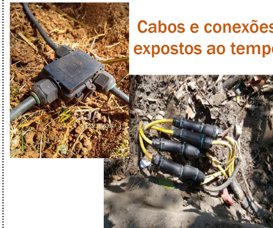
Conector desconectável para intervenções para manutenção ou calibração de instrumentos
